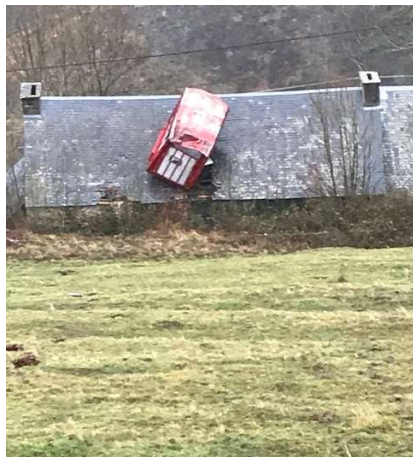
Une bétailère rouge sur le toit d'une grange à Aspin-Aure après les intempéries de décembre 2019
